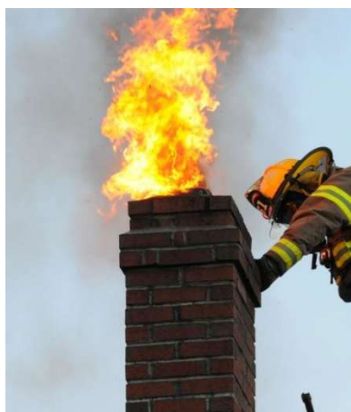
Kaminbrand Temperaturen bis zu 1200°C
