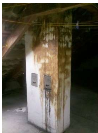
Versottungsschäden (Durchfeuchtung)
